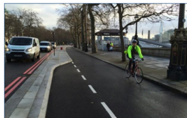
Bild 4: Transport for London (TfL) Super Cycle Highway in London (UK) Variante als invertierte Radverkehrsfläche mit abgesenkter Bordsteinkante zur Vermeidung der Sturzfahrer
